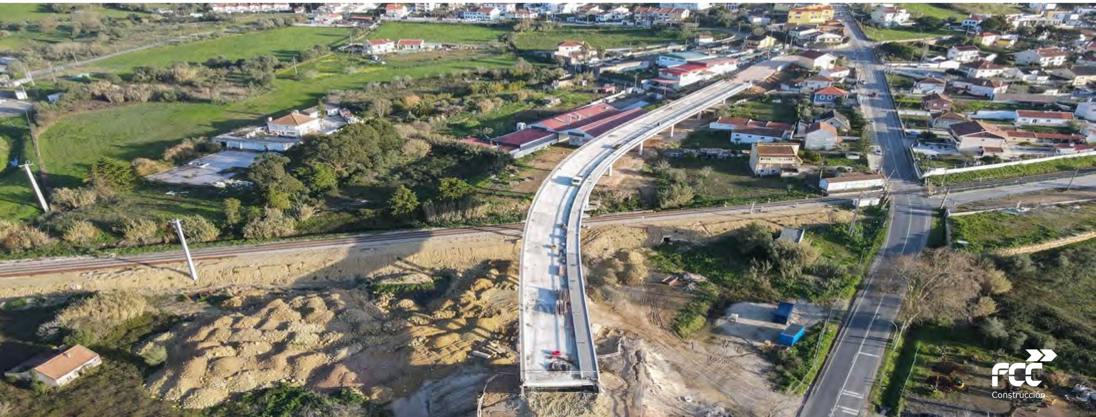
Linha ferroviária do Oeste, Portugal
